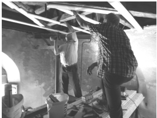
Bild 13: Erneuerung des Balgraumes
